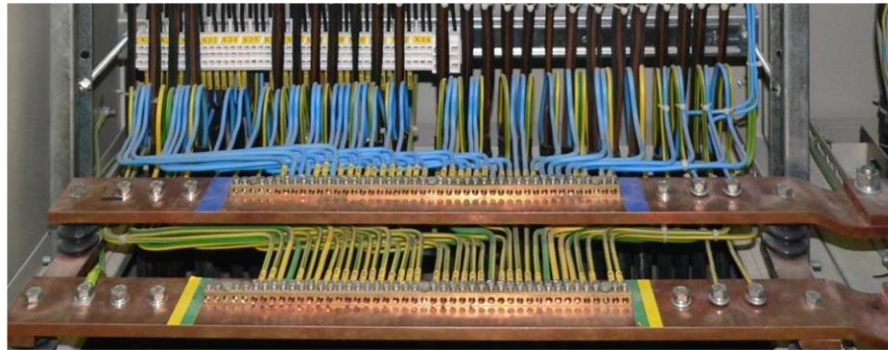
PE and N bridge
