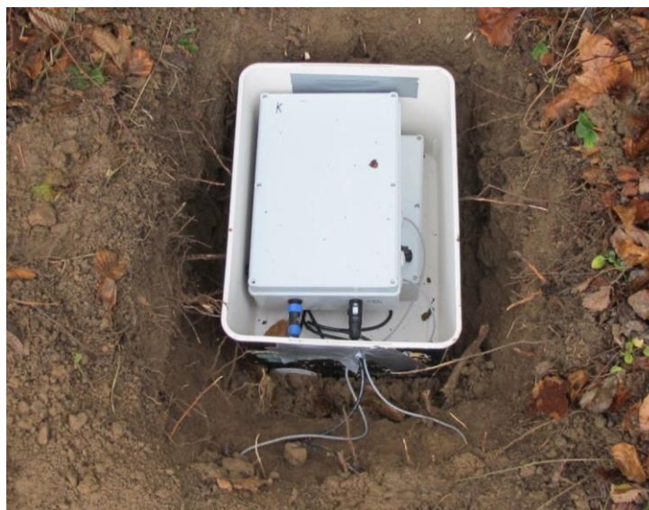
Obr. 1: Umístění měřiče v terénu.
